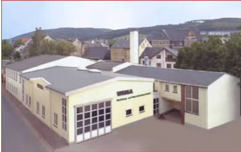
Das Firmengebäude in Olbernhau.
